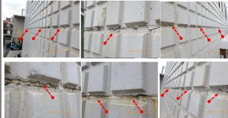
雨漏り目視10箇所目-3として、更に高い位置のひび割れ部分の目視調査の写真を撮ります。中間目地・縦目地に至るまで、シーリングのひび割れが確認されました。次の場所に移ります
