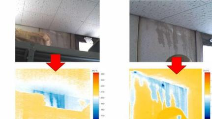
前ページに基づき、倉庫内側サッシ廻り・天井付近から雨漏りが確認されました。水色に変色している箇所が水漏りの部分です。大量の雨漏りが確認されました。次の場所に移動します。
