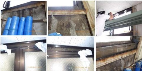
雨漏り調査8箇所目として、ALC外壁中間目地から (3.4.5.6) 付近に30分散水を行いました。散水開始後約12分程度で倉庫内裏側ALC外壁とサッシ部から雨漏りが確認されました。次ページで赤外線映像をご提示します。
